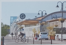
La rénovation d'un quartier de gare (photo extraite du site Picardie.fr)
