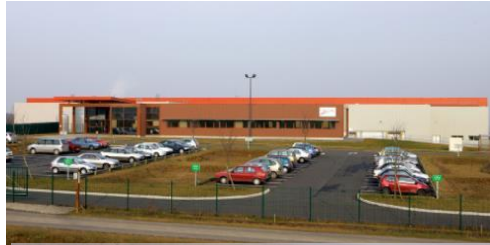
Usine agroalimentaire Bigard, Flixecourt
